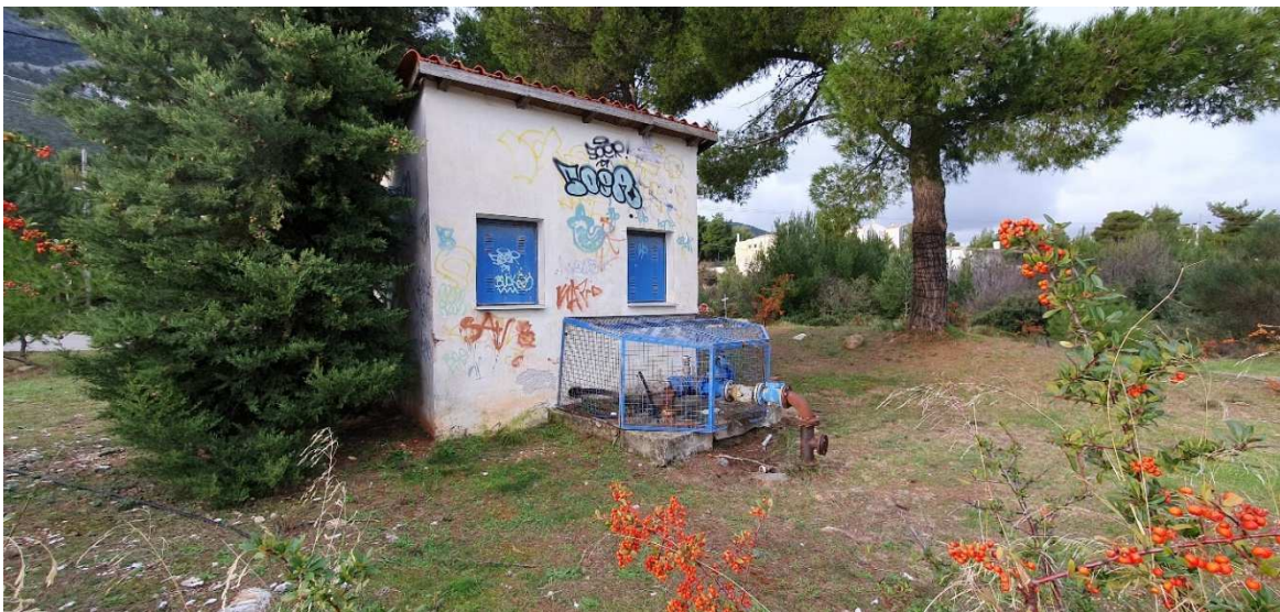
Φωτογραφία 18 : Άποψη Γεώτρησης Αιγαίου
