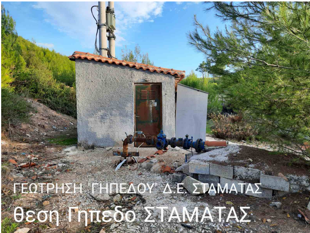
Φωτογραφία 16 : Άποψη Γεώτρησης Γήπεδο
