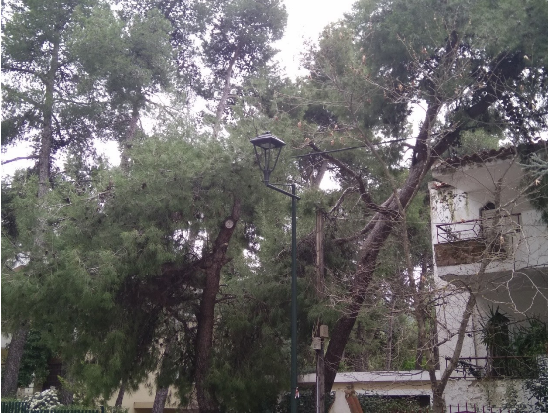
ΦΩΤΟΓΡΑΦΙΑ 12 (Είδη Υπομήματος Γ3, Άρθρο 12) ΦΩΤΙΣΤΙΚΟ ΣΩΜΑ ΤΥΠΟΥ ΦΑΝΑΡΙ ΑΛΟΥΜΙΝΙΟΥ ΤΕΤΡΑΓΩΝΟ ΜΕΓΑΛΟΥ ΜΕΓΕΘΟΥΣ ΜΕ ΤΖΑΜΙΑ ΓΙΑ ΛΑΜΠΤΗΡΑ G12 150W ΚΕΡΑΜΙΚΟΥ ΚΑΥΣΤΗΡΑ (ΟΔΟΣ ΓΡ. ΛΑΜΠΡΑΚΗ ΔΗΜΟΤΙΚΗ ΕΝΟΤΗΤΑ ΔΡΟΣΙΑΣ)
