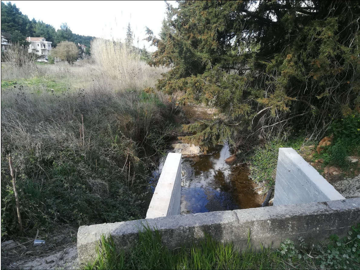
Φωτ. 5: Το ρέμα στην οδό Ειρήνης όπως εξέρχεται από το υφιστάμενο τεχνικό
