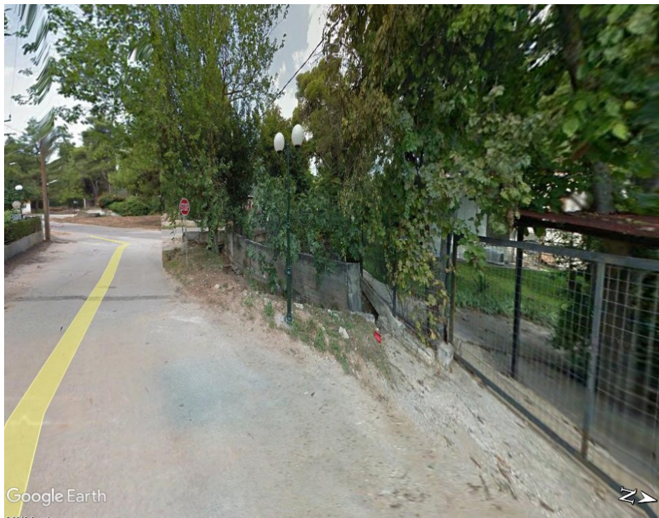
Φωτ.2: Άποψη διέλευσης ρέματος με τεχνικό από σκυρόδεμα (Διατομές 3-4)
