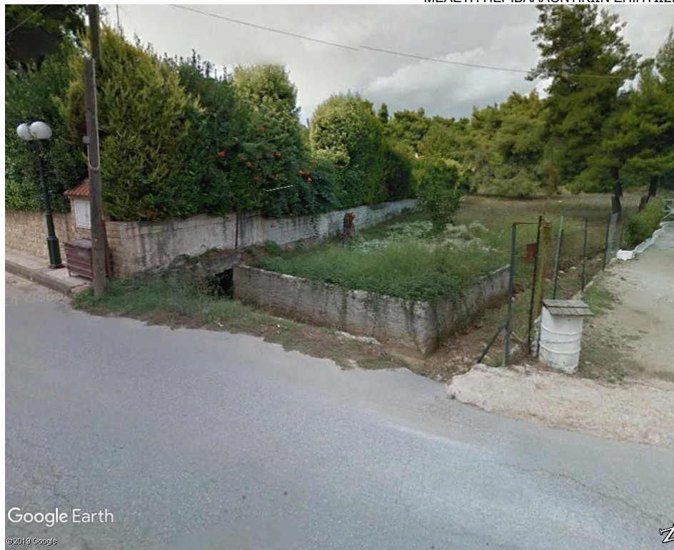
Φωτ.3: Άποψη διέλευσης ρέματος στο όριο ιδιοκτησίας (Διατομές 15-16)
