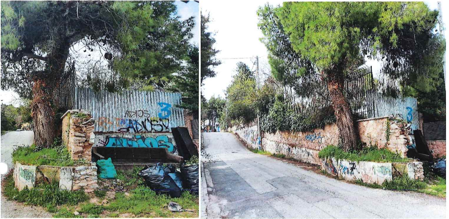
Οδός Τραπεζούντος 25 (Απαιτείται η κατεδάφιση της μάντρας και κατά συνέπεια η απομάκρυνση του πεύκου )
